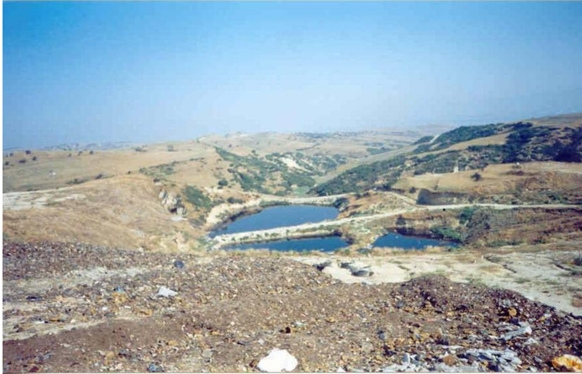
Εικ.5.10: Λίμνη συλλογής ομβρίων σε ΧΥΤΑ.
