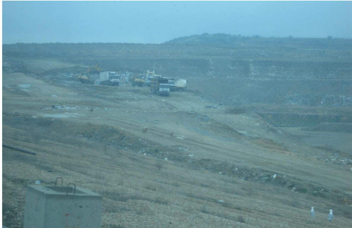
Εικ.5.4: Απόθεση απορριμμάτων σε ημερήσιο κελί στο ΧΥΤΑ Μαυροράχης.
