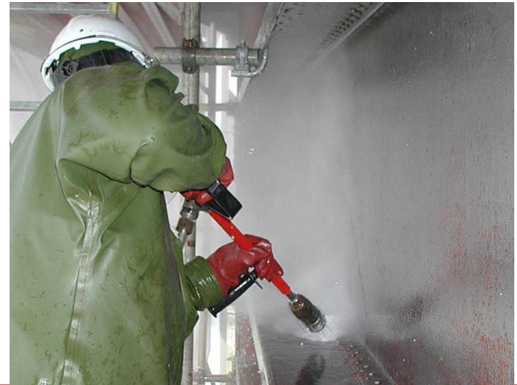
Εικόνα 14: Καθαρισμός με τη βοήθεια εκτόξευσης νερού υπό πίεση.
