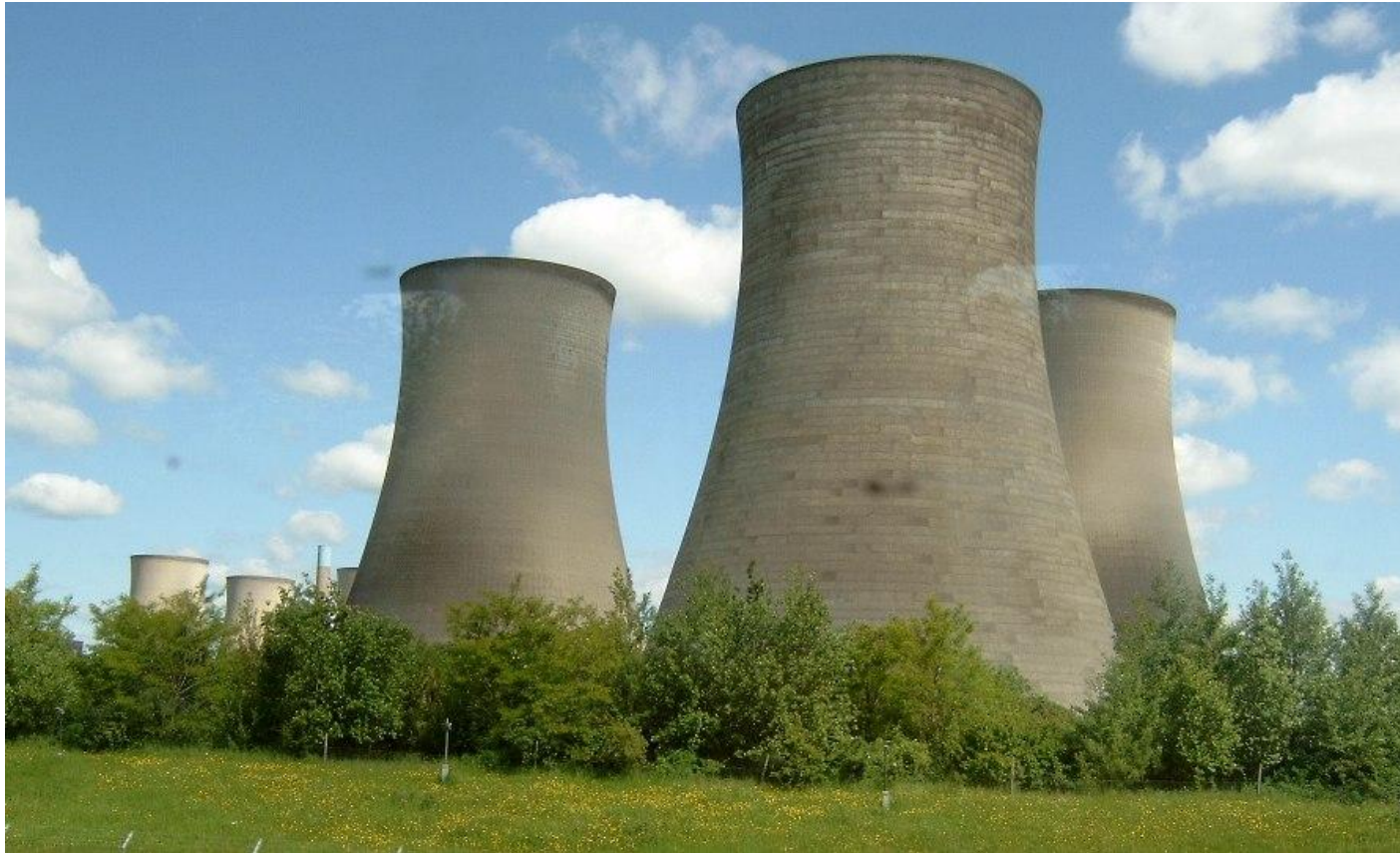
Εικόνα 1: Πύργοι Ψύξης Μονάδας Παραγωγή Ηλεκτρικής Ενέργειας
