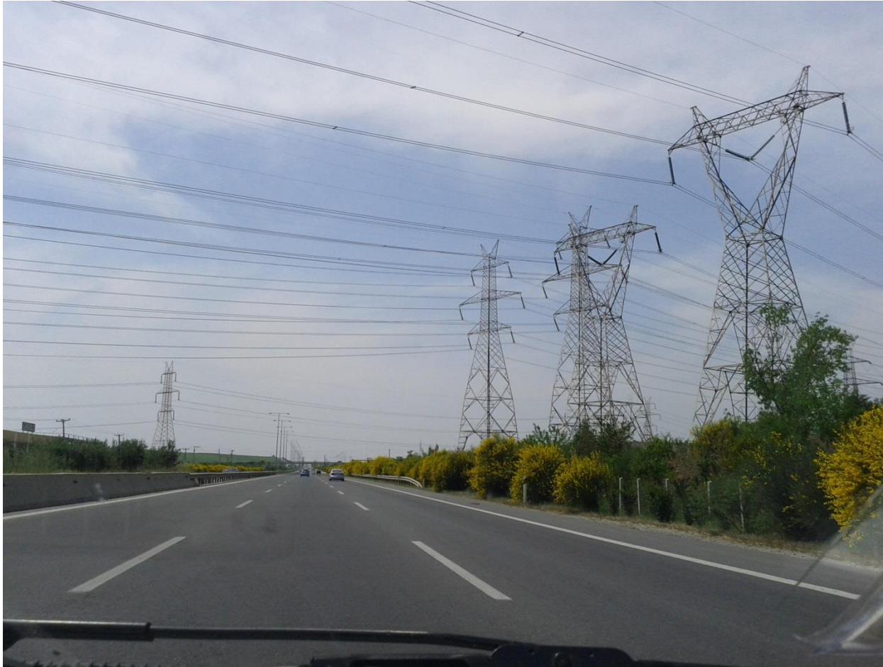
Εικόνα 4: Διάταξη αγωγών ανά φάση
