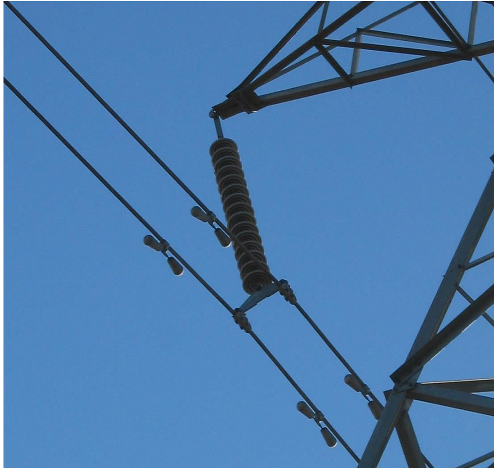
Εικόνα 8: Αποσβέστες Stockbridge
