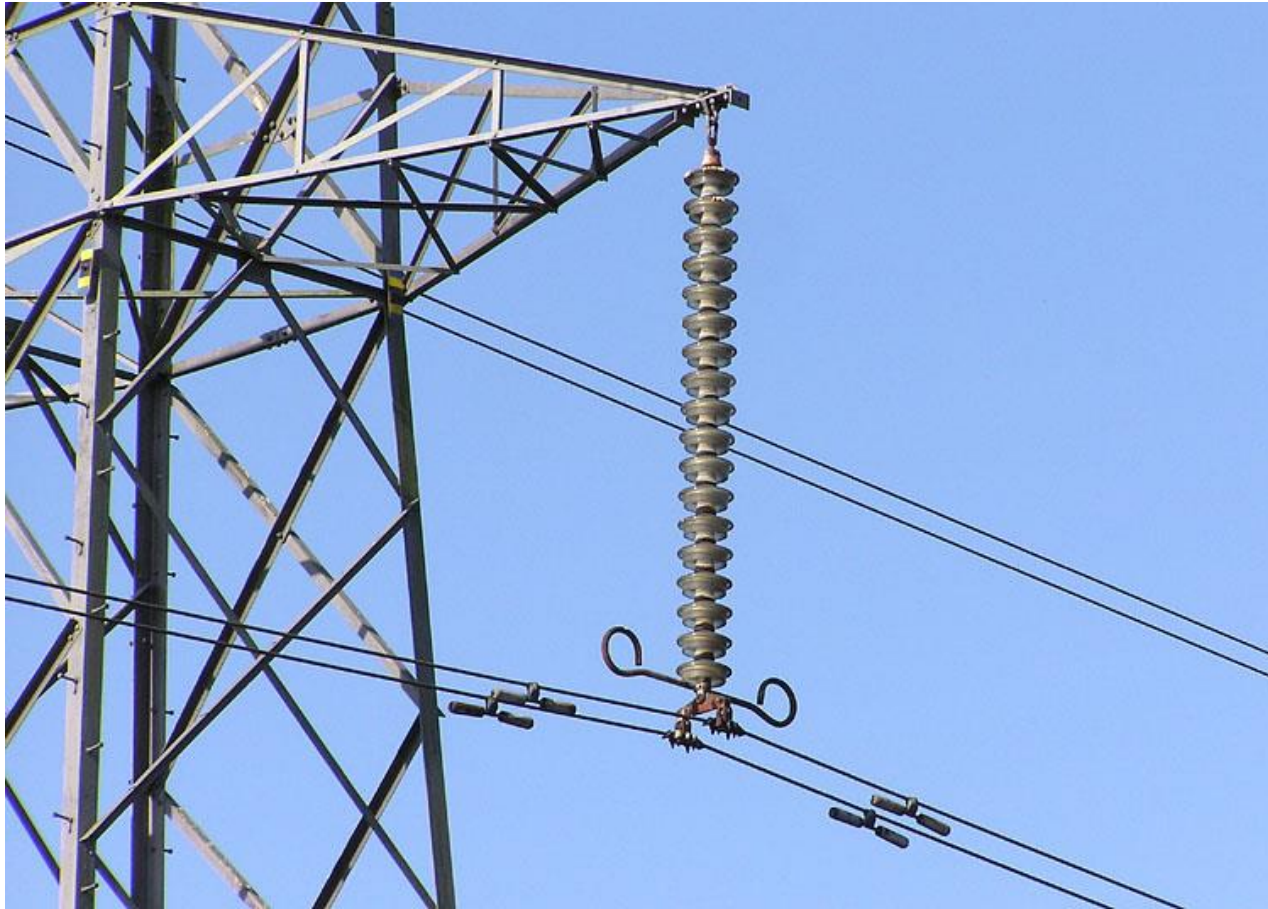
Εικόνα 7: Αποσβέστες Stockbridge
