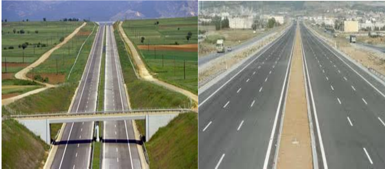
Σχήμα 2: Παραδείγματα αυτοκινητοδρόμου και οδού πολλαπλών λωρίδων κυκλοφορίας - Εγνατία Οδός Α.Ε.
