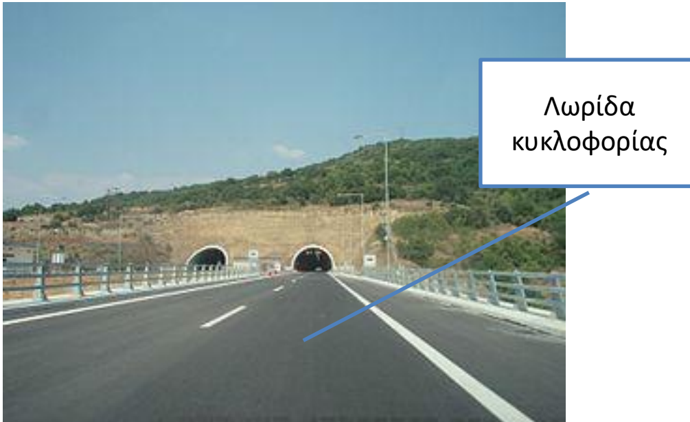
Σχήμα 6: Παράδειγμα Λωρίδας Κυκλοφορίας σε αυτοκινητόδρομο – Εγνατία Οδός Α.Ε.
