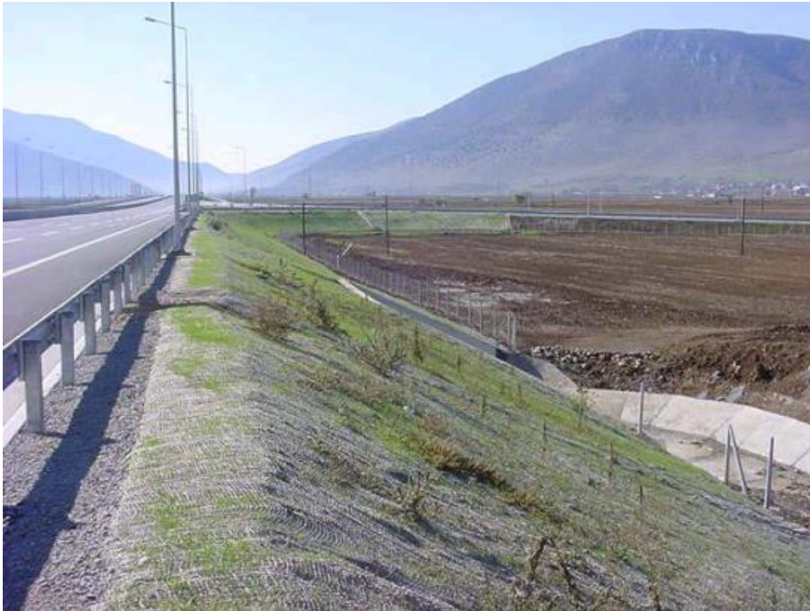
Σχήμα 10: Παράδειγμα πρανούς σε επίχωμα σε αυτοκινητόδρομο – Εγνατία Οδός Α.Ε.
