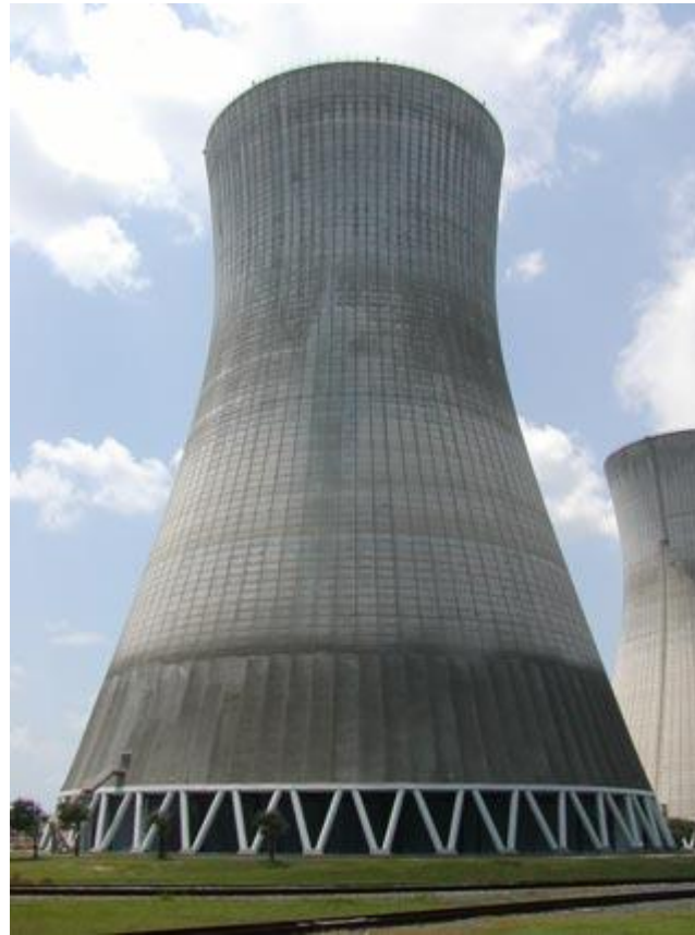
Εικόνα 19: Υγρός πύργος ψύξης φυσικού ελκυσμού
