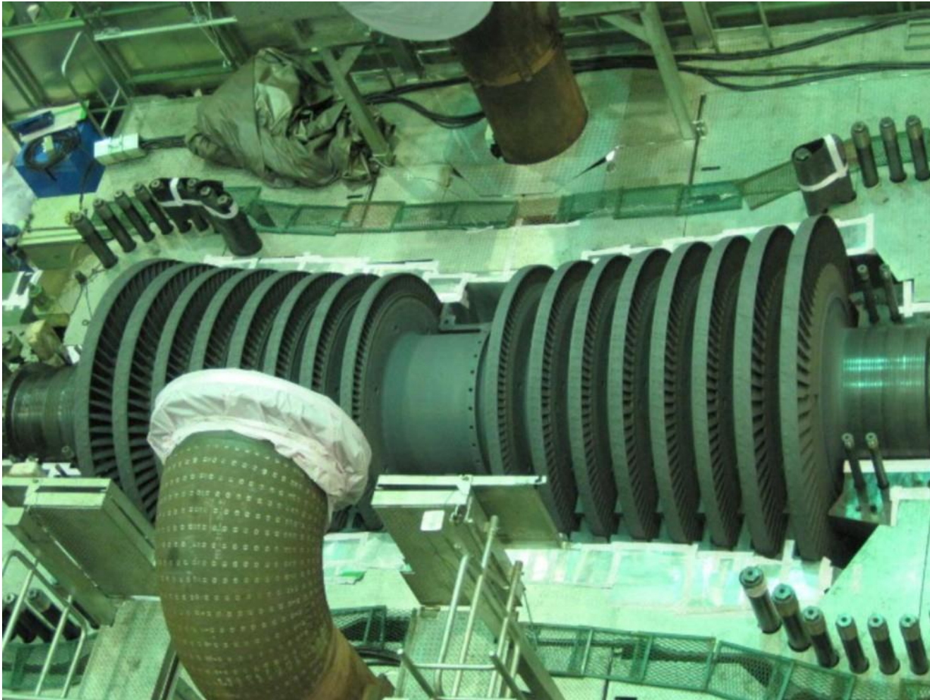
Εικόνα 25: Στροφέιο στροβίλου ΥΠ
