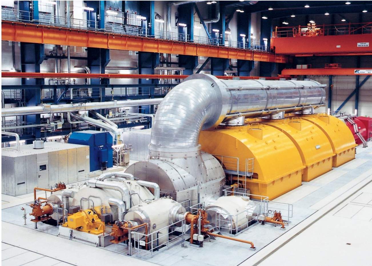
Εικόνα 24: Στροβιλογεννήτρια
