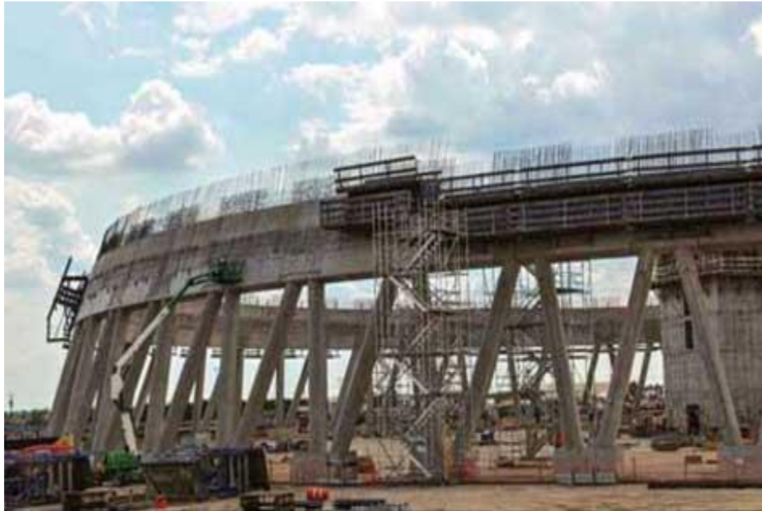
Εικόνα 20: Κατασκευή πύργου ψύξης
