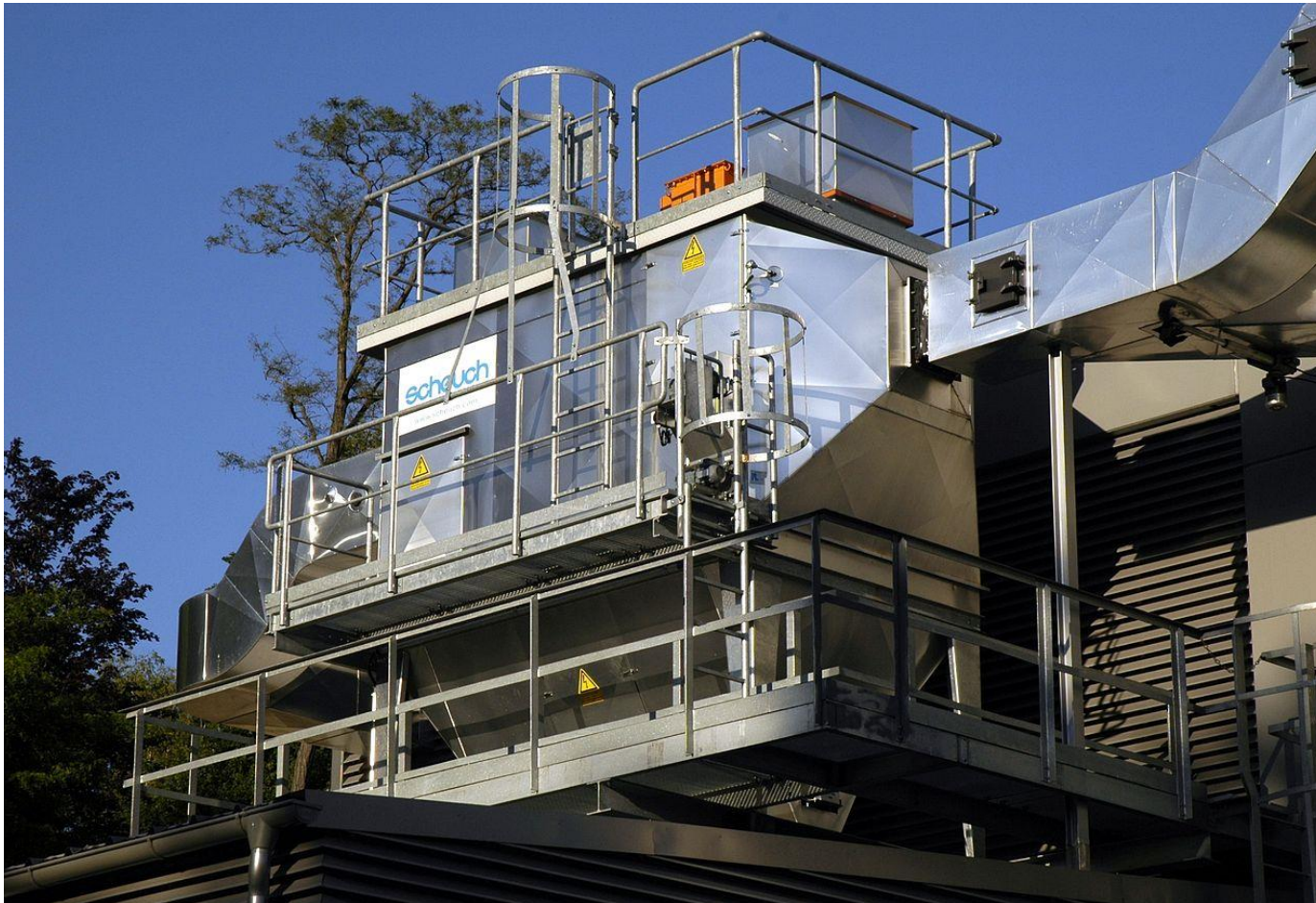
Εικόνα 22: Ηλεκτροστατικό φίλτρο
