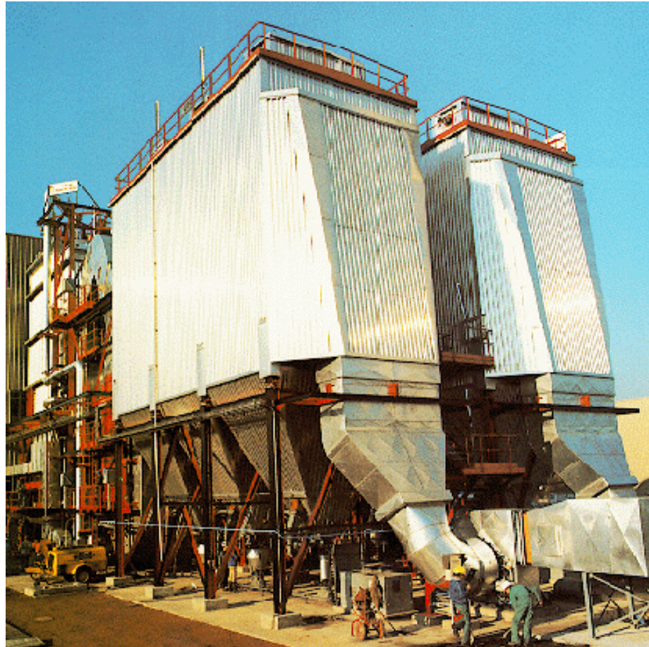
Εικόνα 1: Ηλεκτροστατικό φίλτρο
