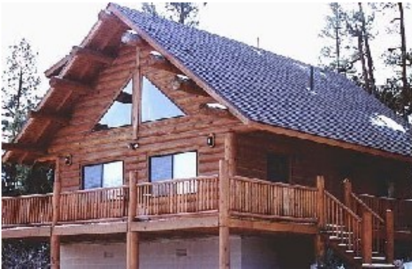
Εικόνα 1.8. Στύλοι και πάσσαλοι σε ξύλινη οικία
