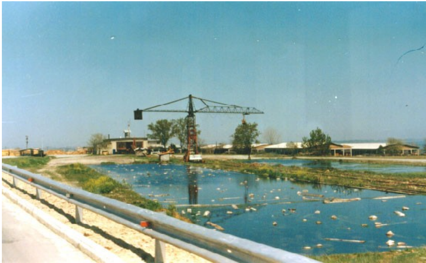
Εικόνα 2.17. Προστασία κορμών με βύθιση σε δεξαμενή
