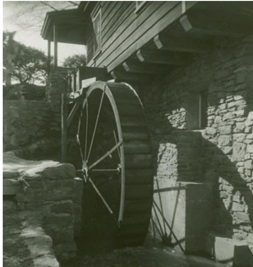
Εικόνα 2.6. Πριστήριο κινούμενο με νερό
