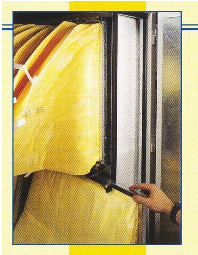
Εικ.21: Έλεγχος αντίστασης φίλτρων
