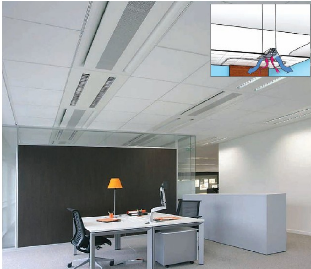
Εικ.76: Chilled beams σε κτίριο γραφείων
