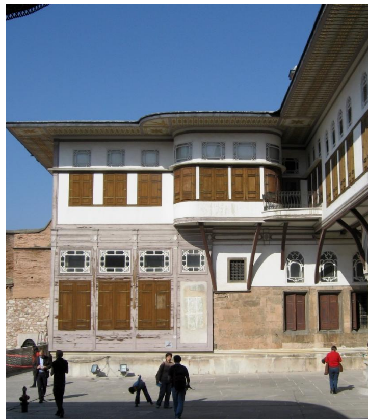
Άποψη της «αυλής των Ευνοουμένων», ανάκτορο Τοπ Καπί , Κωνσταντινούπολη
