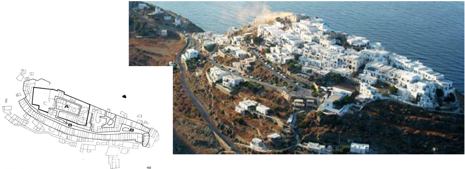
Σίφνος: Το Κάστρο. 181. Τμήμα της νότιας πλευράς (α), προσέλαση (γ), και είσοδος στο Μέσα Κάστρο (δ). 182. Κάτοψη υπό κλίμακα 1:1600. Με παχιά γραμμή σημειώνεται λείψανα του τείχους. α) Μέσα κάστρο, β) έξω κάστρο.
