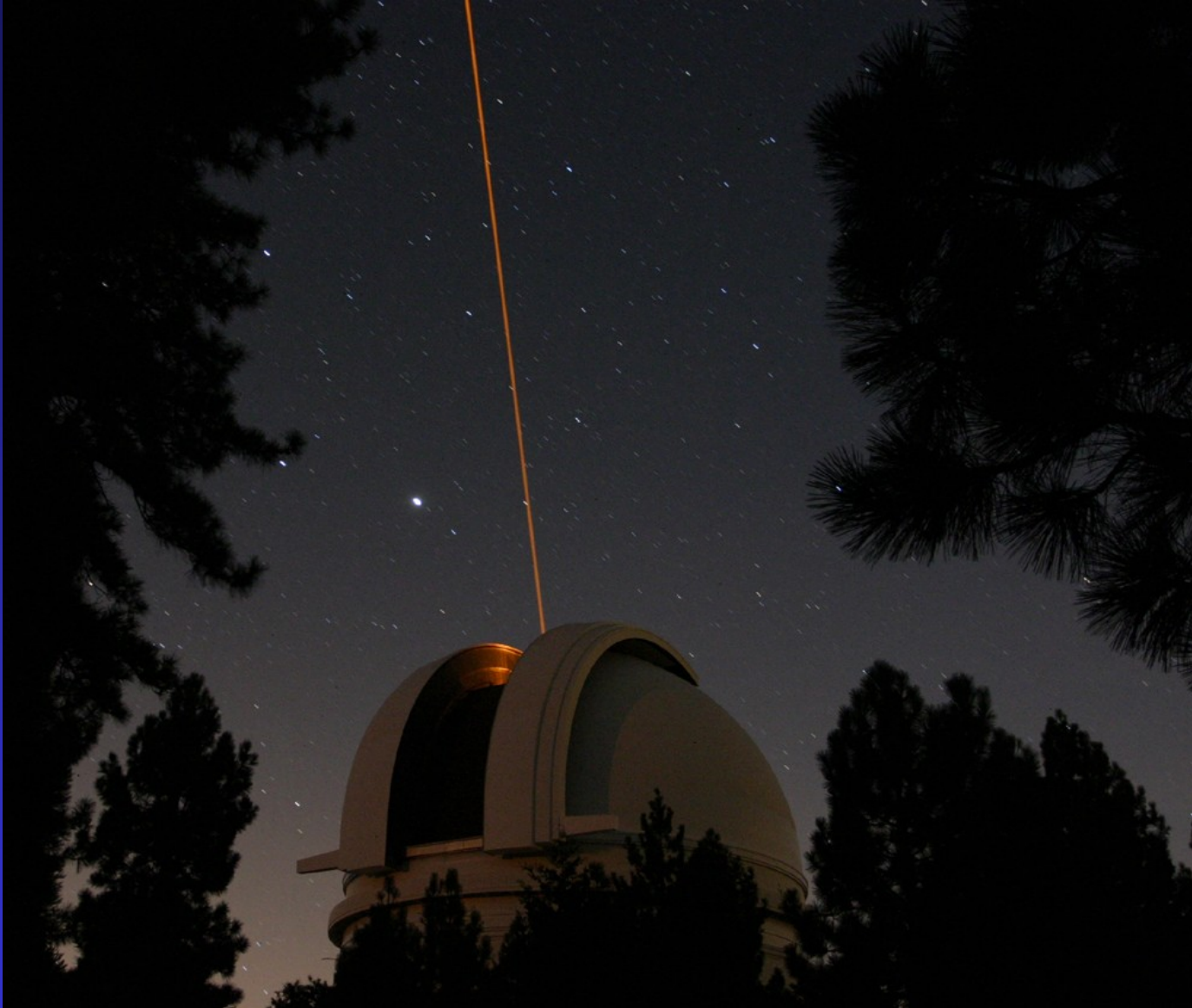
Εικόνα 7: Βελτίωση διακριτικής ικανότητας με χρήση LASER στο τηλεσκόπιο Hale του αστεροσκοπείου Palomar (California, USA) [7].
