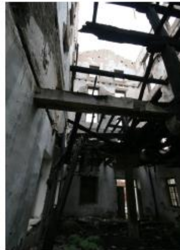
Εικ. 2.25: Φωτογραφία του εσωτερικού του κτιρίου.
