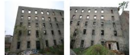
Εικ. 2.26: Αρχικές φωτογραφίες της βορειοδυτικής όψης.
