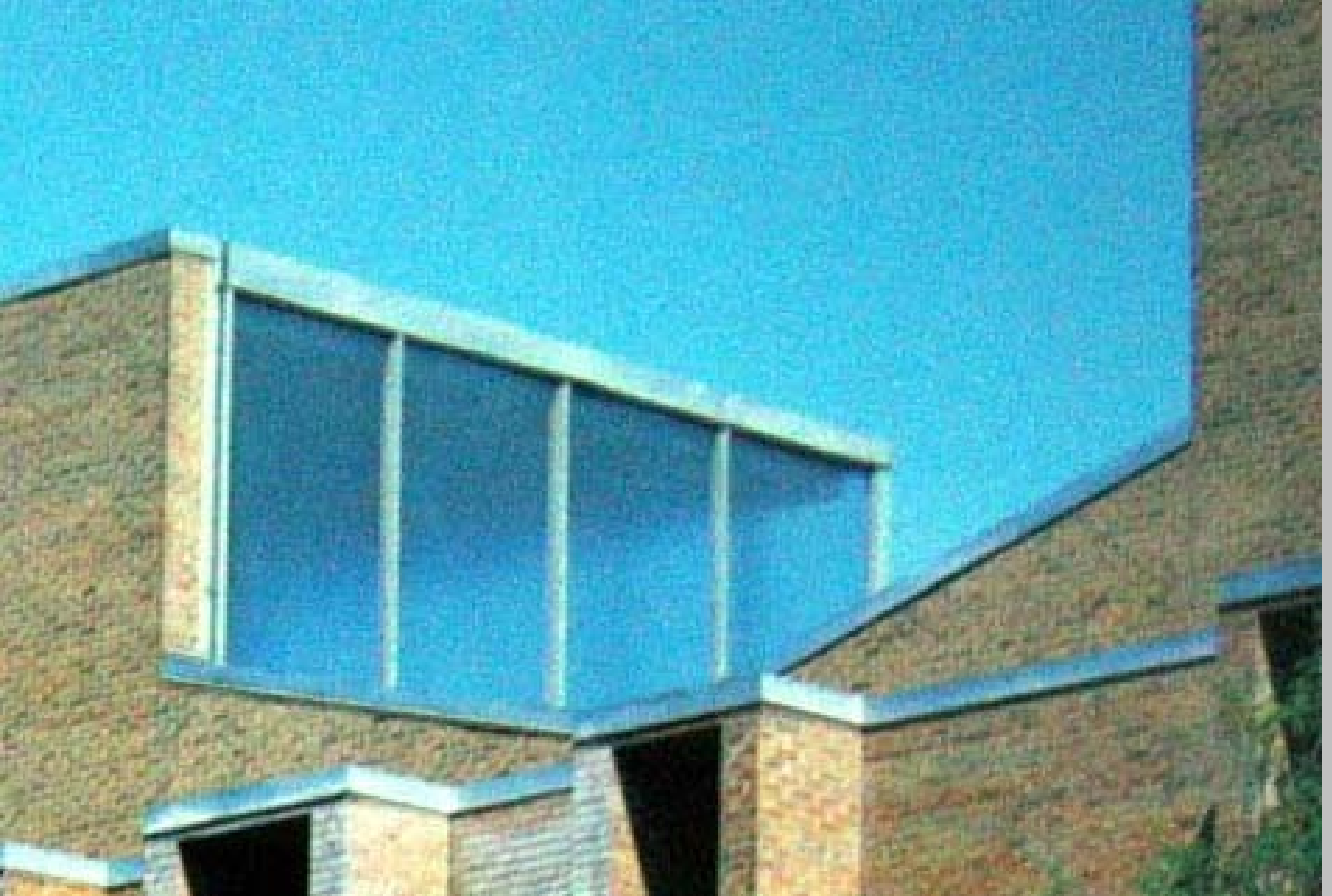
Πρώτη Εκκλησία Ενωτικών, πόλη του Ρότσεστερ, Νέα Υόρκη. Πλάγιες γραμμές στην μέση - 13^\circ κλίση. 25
