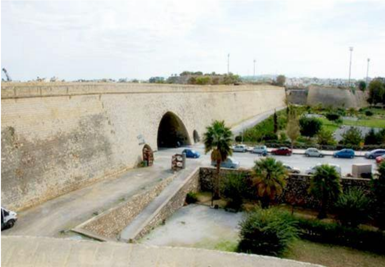
Εικόνα 2. Άλλη άποψη των ενετικών τειχών.
