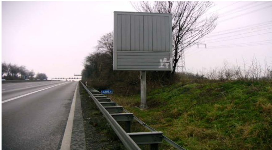
Συμπαγής ορθοστάτης πινακίδας μη ανατρεπόμενος και μη παραμορφώσιμος → Κατηγορία κινδύνου 3
