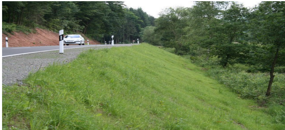
Πρανή επιχωμάτων H > 3m και ορυγμάτων με κλίση υ:β > 1:3 → Κατηγορία κινδύνου 4
