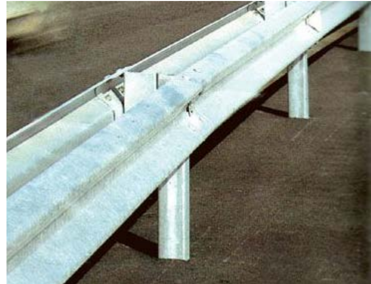
Εικόνα 5: Παράδειγμα μεταλλικού αμφίπλευρου στηθαίου ασφαλείας
