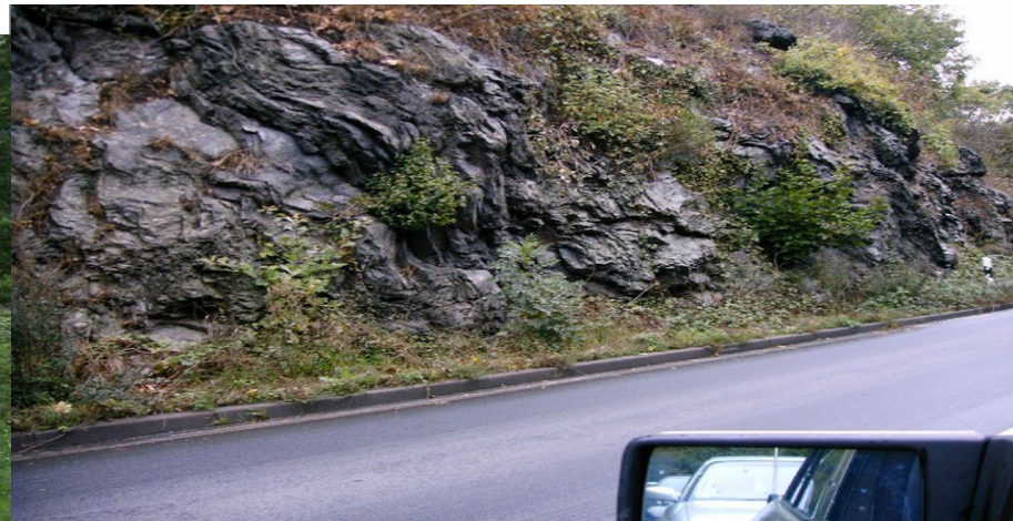
Πρανή επιχωμάτων H > 3m και ορυγμάτων με κλίση υ:β > 1:3 → Κατηγορία κινδύνου 4
