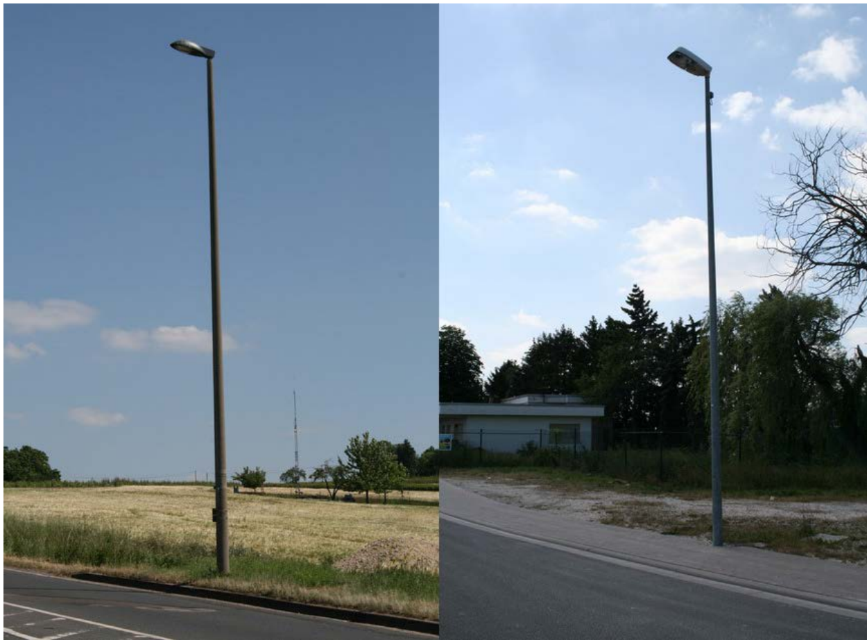
Συμπαγής ιστός οδοφωτισμού → Κατηγορία κινδύνου 3
