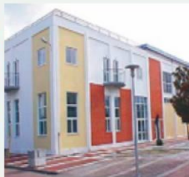
Κέντρο νεολαίας και άθλησης πρώην κλωστοϋφαντουργείο Αδαμόπουλου
