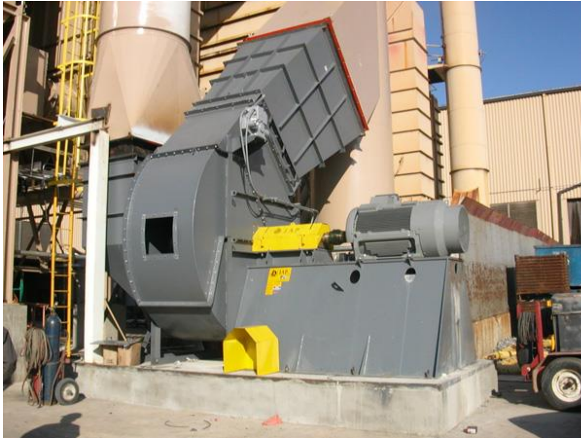
Εικόνα 3: Ανεμιστήρας ελκυσμού
